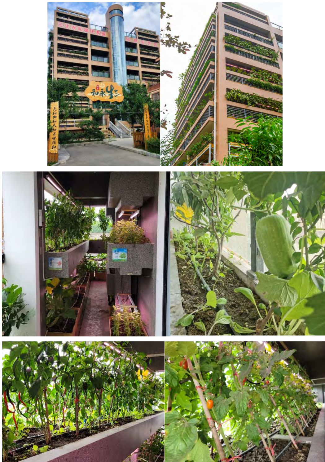
图1 “三生永和循环系统”样板楼农业生产实景图
